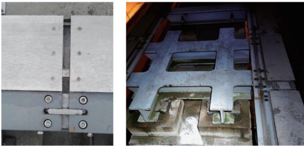
图2 轨道接头示意图 Fig. 2 Schematic diagram of guideway joint
